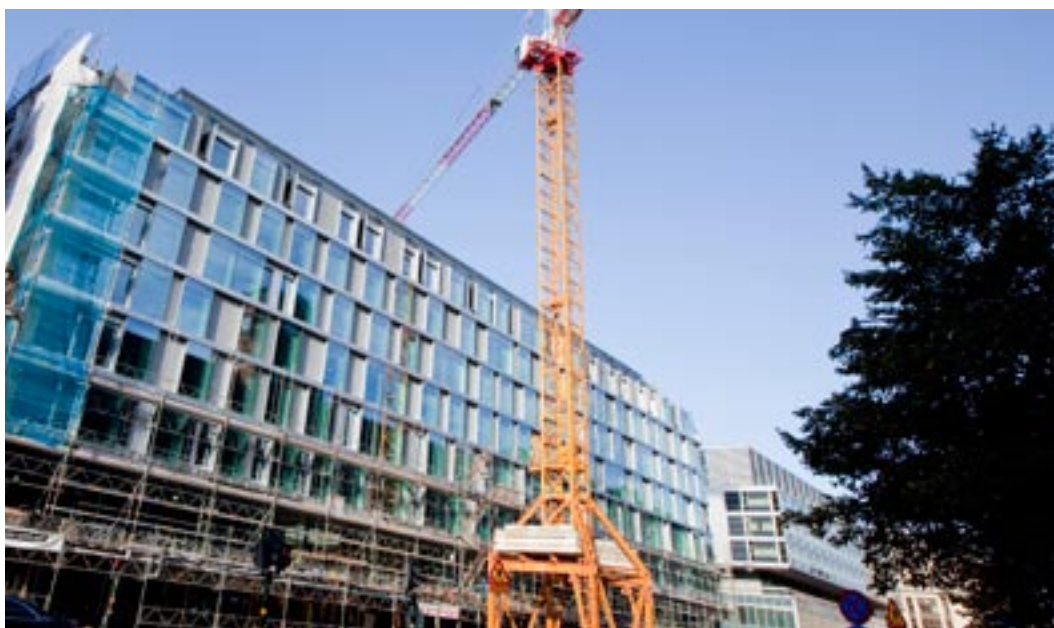
Som första fastighet i Sverige har Vasakronans ombyggnadsprojekt i kvarteret Pennfåktaren i Stockholm pre-certifierats på guldnivå enligt LEED.
