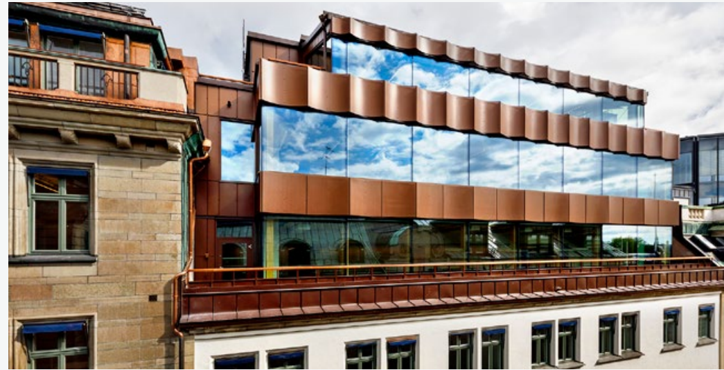
Bankpalatset vid Kungsträdgården i Stockholm är ett exempel på en befintlig fastighet som för ett par år sedan varsamt totalrenoverades och då fick en påbyggnad i trä med utvändig plåt- och glasfasad.
