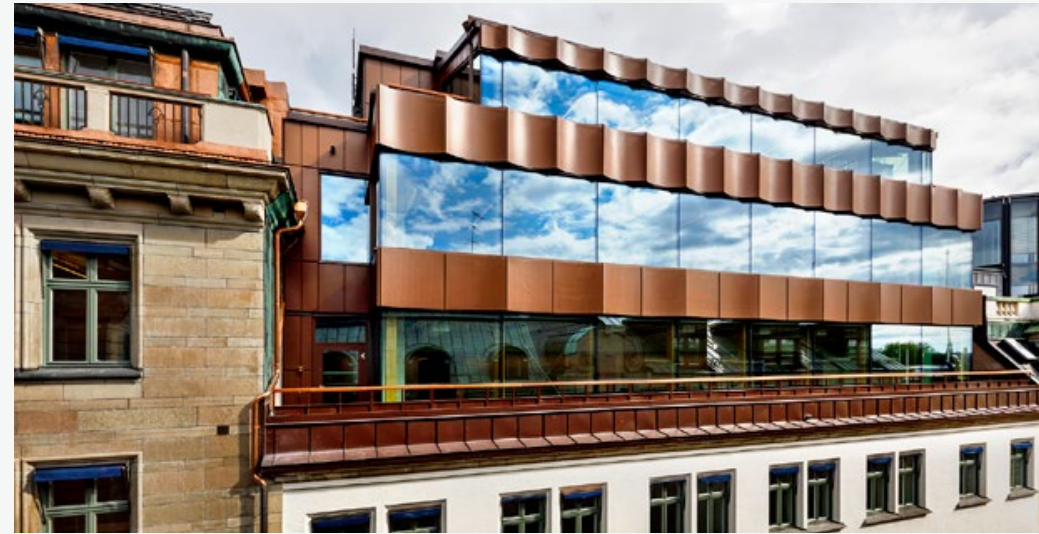
Bankpalatset vid Kungsträdgården i Stockholm är ett exempel på en befintlig fastighet som för ett par år sedan varsamt totalrenoverades och då fick en påbyggnad i trä med utvändigt plåt- och glasfasad.
