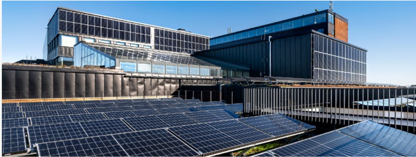
Solceller på tak och fasad samt kyla och värme från borrhålslager är några av finesserna som gjorde Nya Kronan i Sundbyberg till vinnare av Årets bygge 2022.
