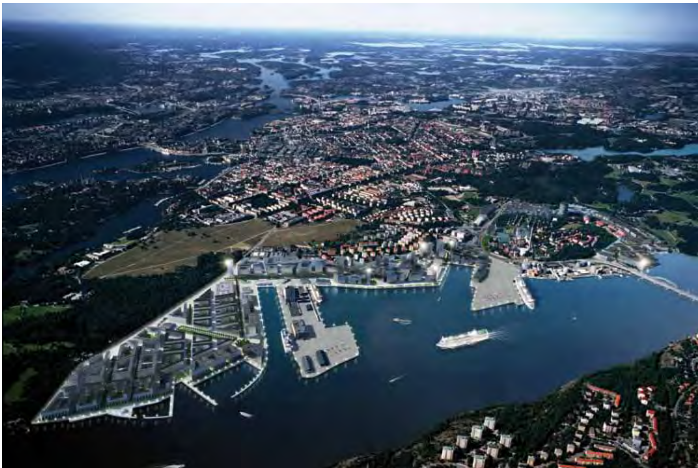
Norra Djurgårdsstaden är ett av Stockholms miljöprofilerade utvecklingsområden med siktet inställt på att bli klimatpositivt. Som största fastighetsägare i området arbetar Vasakronan tillsammans med Stockholms stad för att utveckla Norra Djurgårdsstaden till en internationell förebild för hållbar stadsutveckling.
